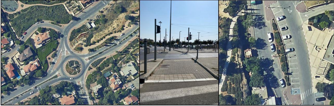
صور رقم (7): مواقف السيارات وممرات المشاة والجزر في الطرق التي يستخدمها المستوطنون المصدر: صورة جوية 2018، بتصرف الباحثة. الجعبري 2020
